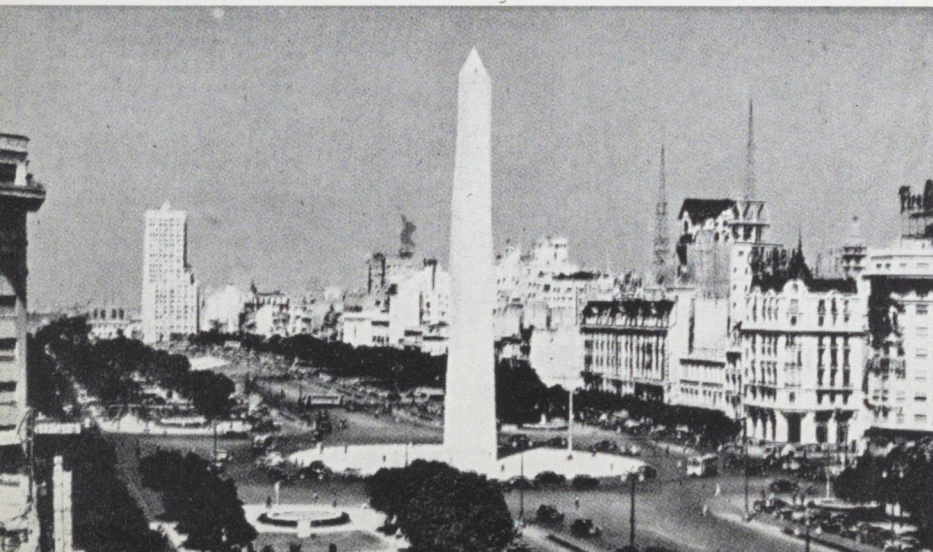
Avenida Nove de Julho, Buenos Aires.
